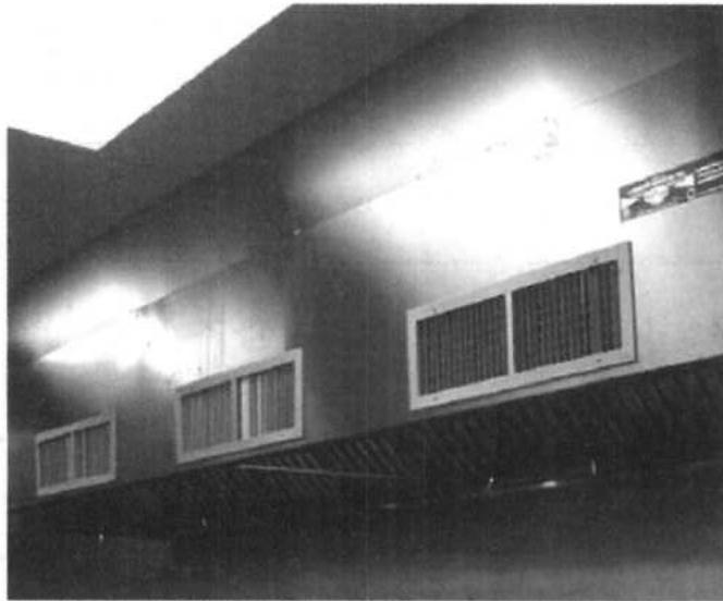
شکل (۱۴-۵-۱۳): نمونه‌ای از هود با درجه هوای جایگزین روی پیشانی آن
