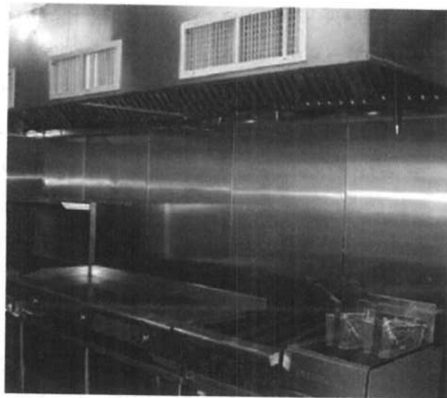
شکل (۱۴-۵-۷): نصب هود کانوپی بر روی چند وسیله پخت و پز
